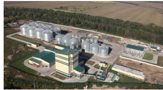
30 т/год комбікормовий завод і 78, тис. тонн зерносквище ТОВ «Комбі», ГК Агропромкомплектація, Росія, 2012 рік
